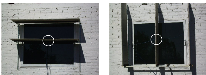
Figura 5 – Brises horizontal e vertical, com termopares instalados.
