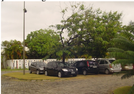
Figura 14 - Fachada noroeste do CAPC (LUKIANCHUKI, 2010).
