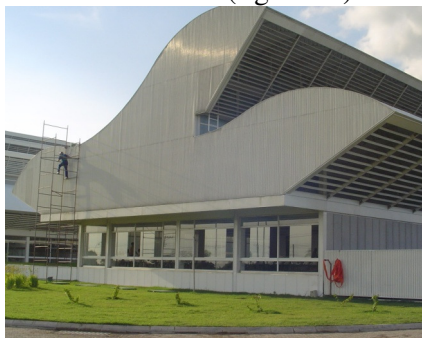
Figura 17 - Fachada sul - bloco de serviços (LUKIANCHUKI, 2010)
