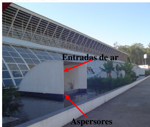
Figura 8 – Entrada de ar das galerias
