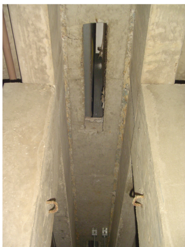
Figura 10 – Vão entre as paredes por onde circula o ar
