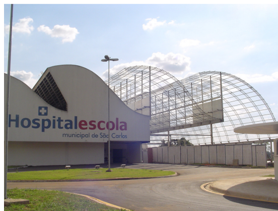
Figura 6 – Treliças metálicas dos sheds
