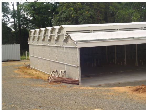
Figura 5 – Paredes externas de alvenaria de tijolo
