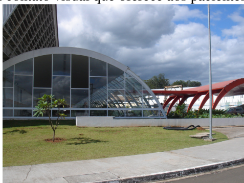
Figura 3 – Grama ao redor do edifício
