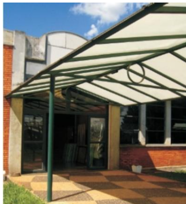
Figura 1 – Cobertura de Policarbonato.
