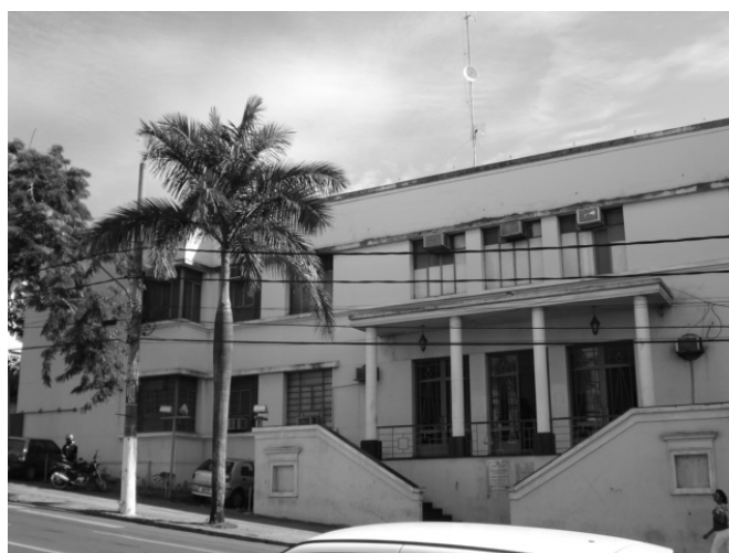
Figura 5 - Fachada Principal do edifício do Juizado Criminal
