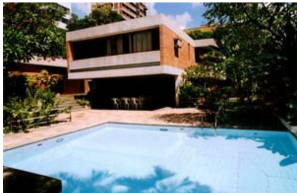
Figura 5: Residência Emir Glasner (1972), Recife. Arquiteto Vital M. T. Pessoa de Melo. Fonte: Foto de Aurelina Moura. Arqtextos 086
