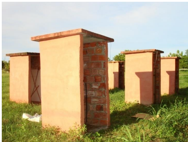
Figura 02 – Protótipos de alvenaria e cobertura de laje de concreto
