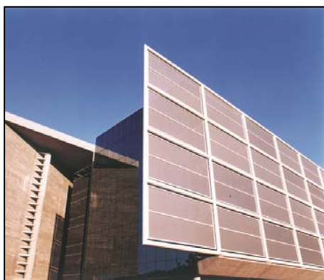
Figura 2: Proteção com tela na fachada oeste do prédio P&D fonte: Roberto Loeb Arquitetura
