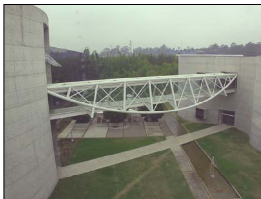
Figura 5: Passarela de acesso do bloco da recepção para o administrativo Fonte: Autora
