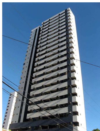
Figura 06 – Edifício Preto: fachada principal Fonte: arquivo pessoal
