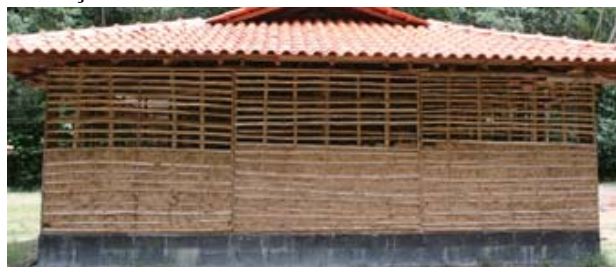
Figura 5 – Painel assentado na base de concreto, sendo preenchido com a mistura de barro-bambu
