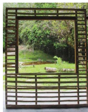
Figura 4 – Painel de bambu com janela (RIBEIRO; RIBEIRO, 2010)
