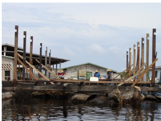
Figura 7 – Processo de construção do flutuante (Josivaldo Modesto)
