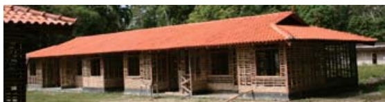
Figura 1 – Um dos blocos da vila sendo construído (RIBEIRO; RIBEIRO, 2010)
