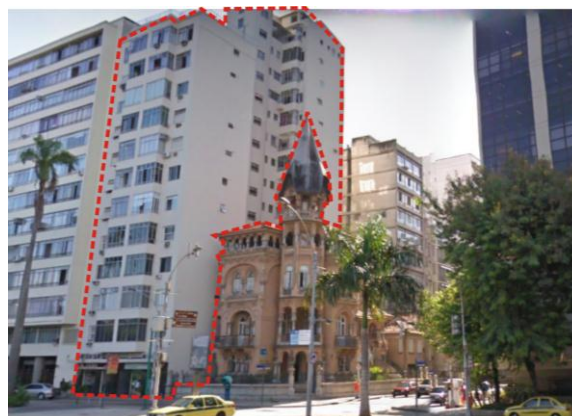
Figura 2 – Vista panorâmica do edifício (em vermelho) e entorno imediato. Fonte: GOOGLE, 2010.
