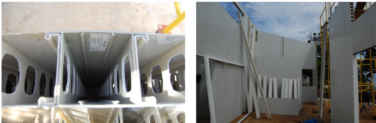
Figura 2 – À esquerda, detalhe do encaixe entre cada módulo do sistema construtivo; e à direita, painéis de PVC durante a montagem da ECIT (RODRIGUES et al. , 2010).
