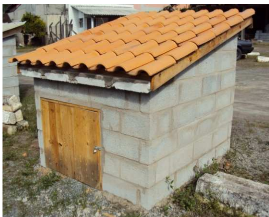
Figura 05 - Célula-teste 03. Laje sem isolamento térmico + cobertura vegetal
