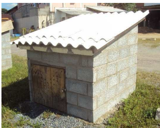
Figura 07 - Célula-teste 05. Laje com isolamento térmico + telha de fibrocimento
