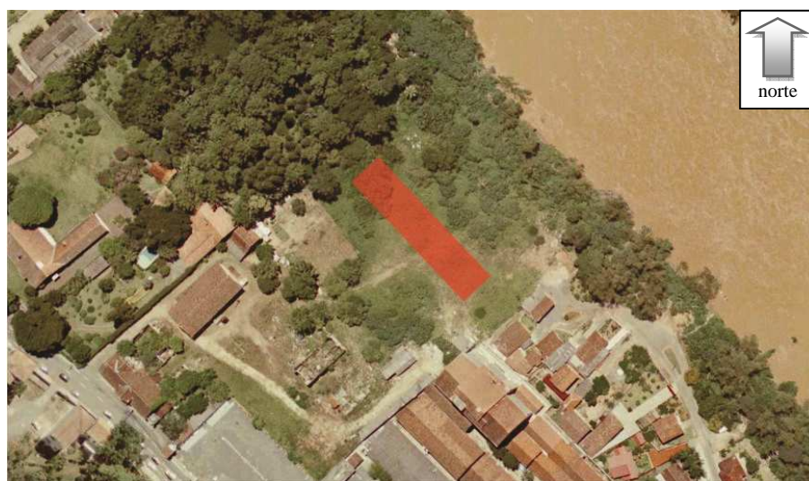
Figura 01. Aérea de locação das células-testes; a hachura vermelha demarca o local onde foram construídas. Escala: 1/5000 Fonte: Arquivo disponível para estudantes da Universidade Regional de Blumenau
