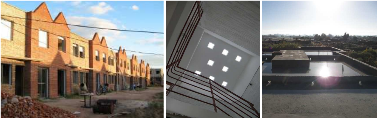
Figuras 09, 10 y 11. - Cooperativa COVI 2000, Uruguay, casas en obra- figura 9, Iluminación natural de escalera- figura 10 y azoteas inundadas para reducir ganancias solares y recolectar aguas lluvias- figura 11. ( www.sonico.com/publico/500002393/covi-2000 )
