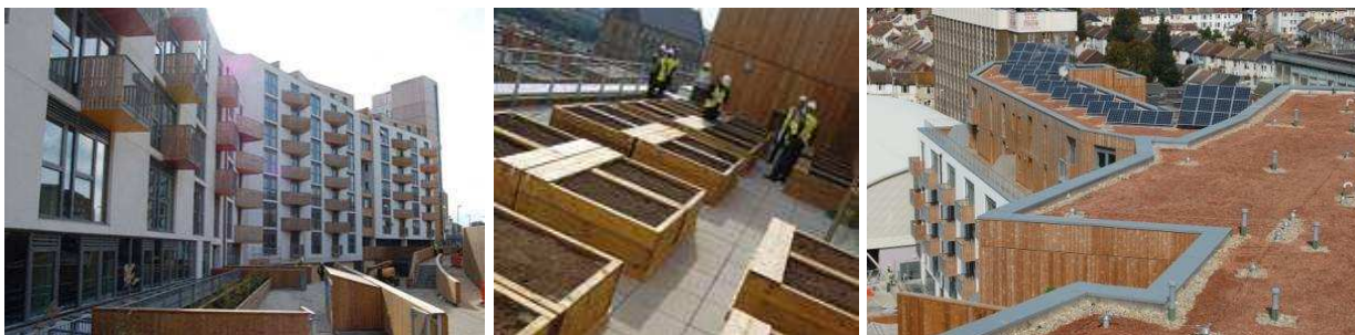
Figura 5 Edificio “Brighton Belle” One Brighton, Brighton, Inglaterra. (foto www.onebrighton.co.uk ) Figura 6 Huertas arriba del techo. (foto www.oneplanetcommunities.org ) Figura 7 Fotovoltaicos y techo ecológico extensivo. (foto www.rtpi.org.uk )
