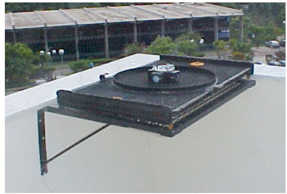
Figura 4 – Conjunto cruzeta-fotocélulas-aro montado sobre base na estação (SANTOS, 2003).
