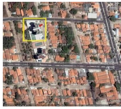
Figura 3- Situação do edifício 4
