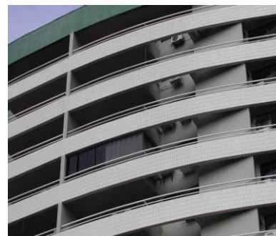
Figura 6 - Fachada Edifício 4, de uso residencial, com 12 pavimentos
