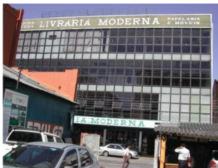
Figura 5 - Fachada Edifício 2, de uso comercial, com Térreo + 3 pavimentos
