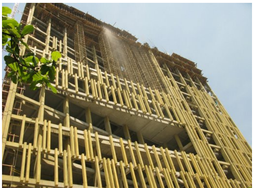
Figura 14 – Fotografía del avance de las obras a junio de 2009. Fachada norte.
