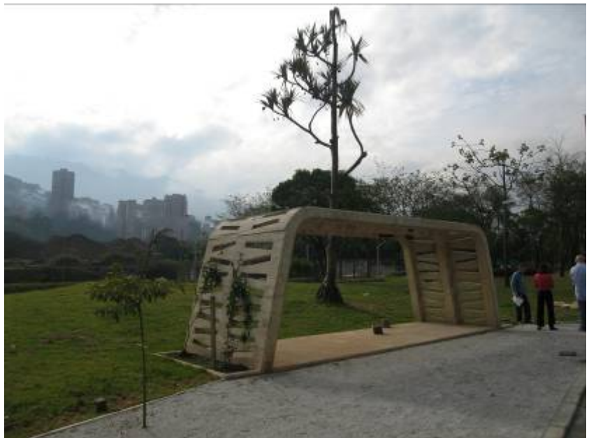
Figura 1 – Estado de avance de las obras del Parque de los Colores, ubicado cerca al centro de la ciudad de Medellín en Febrero de 2009. ARRIBA: Zona para jóvenes. ABAJO: Zona para espera de buses. (Fotografía S+A Arquitectos.)
