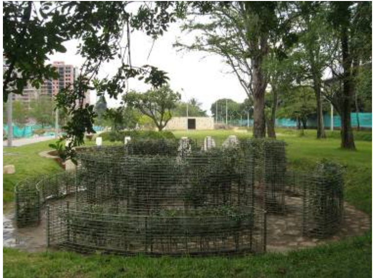
Figura 11 – Avances de las obras a febrero de 2009. Fotografía S+A Arquitectos.
