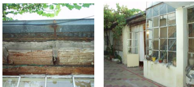
Figura 8 Composición de la cubierta y los elementos de la envolvente vidriados que cierran la galería.
