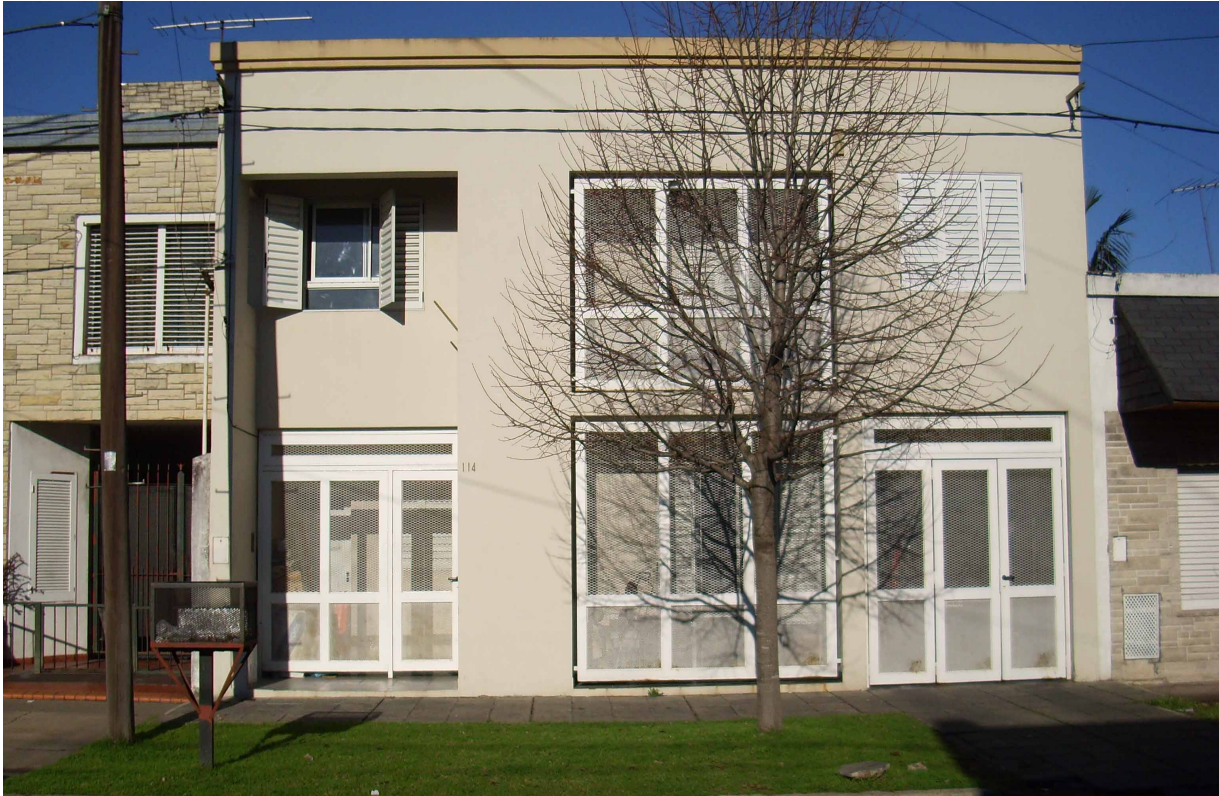
Figura 2: Fachada noroeste de la vivienda (Foto 07-2008).
