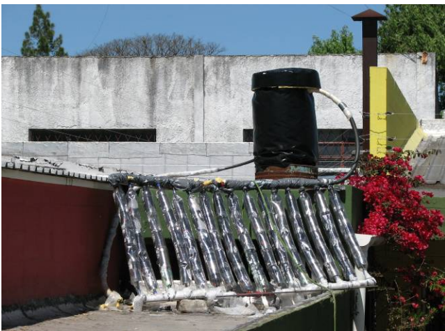
Fig. 3. Colector dinámico de botellas construido en los talleres e instalado en el local de Tacurú
