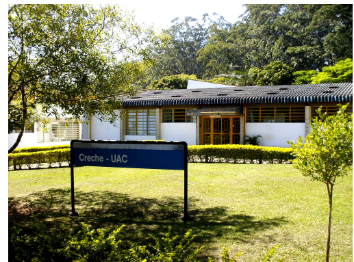
Figura 1 – Vista externa da UAC
