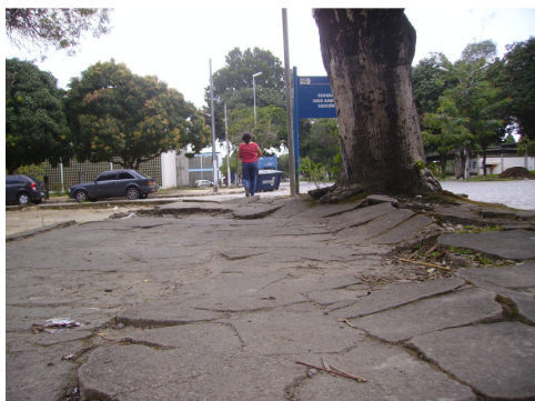
Figura 1 - O mau estado de conservação de parte do calçamento do Campus A. C. Simões da UFAL aponta para a necessidade de reformas que promovam maior acessibilidade no local (Fonte: Autores).
