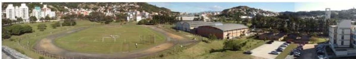
Figura 6 – Vista panorâmica da cobertura do prédio
