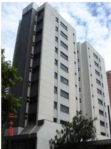
Figura 2 – Fotografia do Edifício Comercial Ouro Verde
