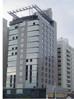
Figura 2 - Imagem da fachada em fase de construção (junho 2006).
