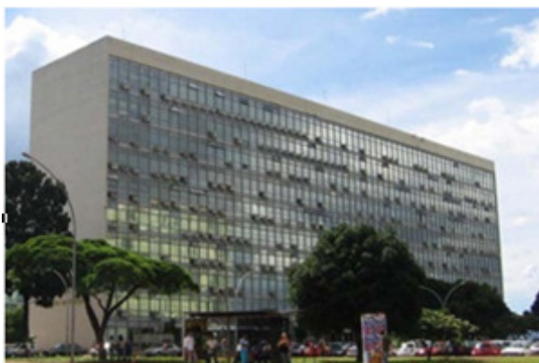
Figura 2 – Fachada leste do edifício
