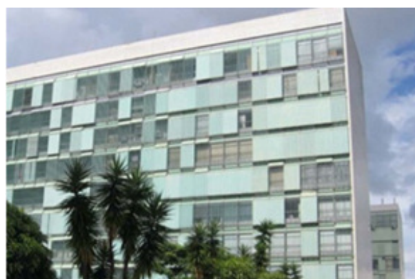
Figura 3 – Fachada oeste do edifício
