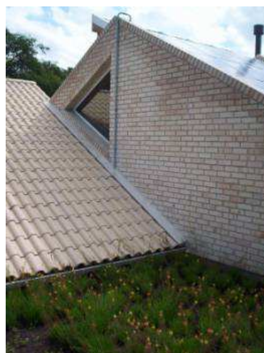
Figura 8 – Telhado cerâmico (quarto de casal) e telhado vegetado (quarto de solteiro).
