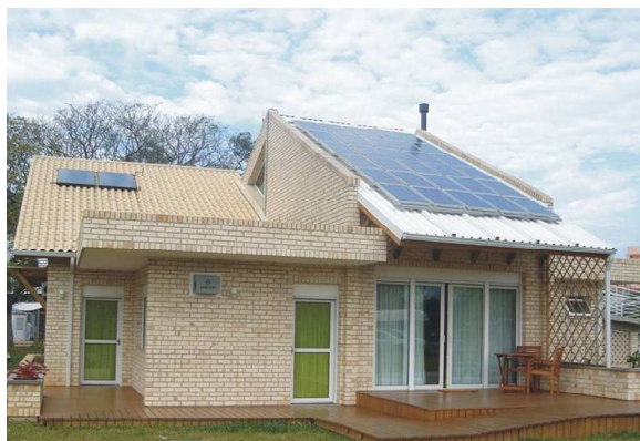
Figura 2 – Vista externa da Casa Eficiente (fachada norte).
