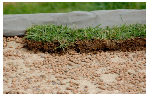
Figura 06 - Construção da cobertura vegetal.
