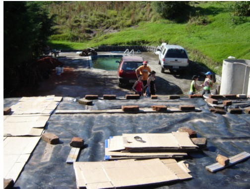
Figura 2 – Instalação da lona e selamento das juntas.
