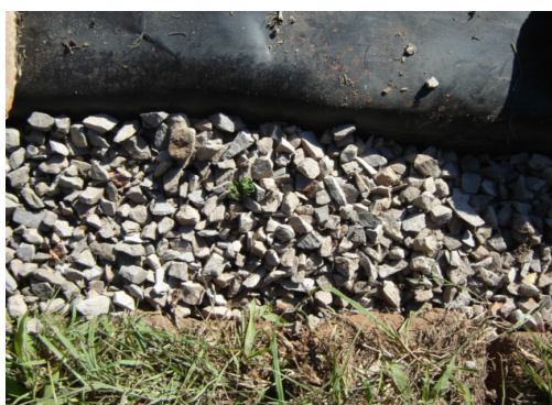
Figura 9 – Detalhe da calha com a leiva.
