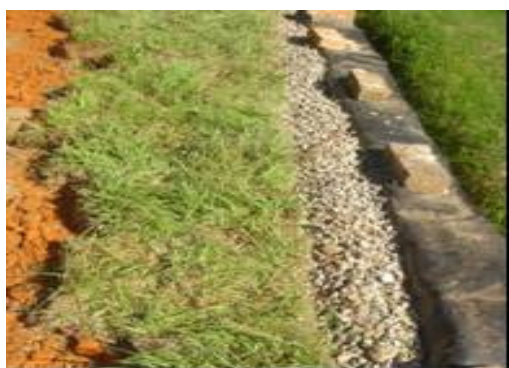
Figura 8 – Instalação da britas nas laterais do telhado.
