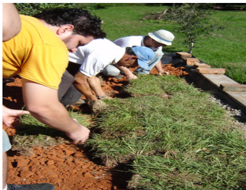
Figura 7 – Colocação das leivas sobre a camada de solo.
