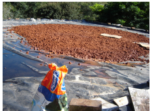
Figura 4 – Distribuição do substrato sobre a lona.
