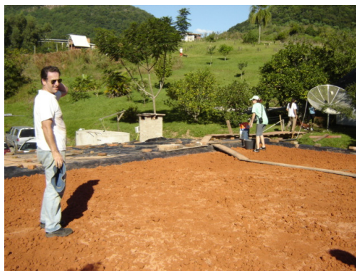
Figura 5 – Introdução da camada de solo sobre a camada de pedaços de tijolos.
