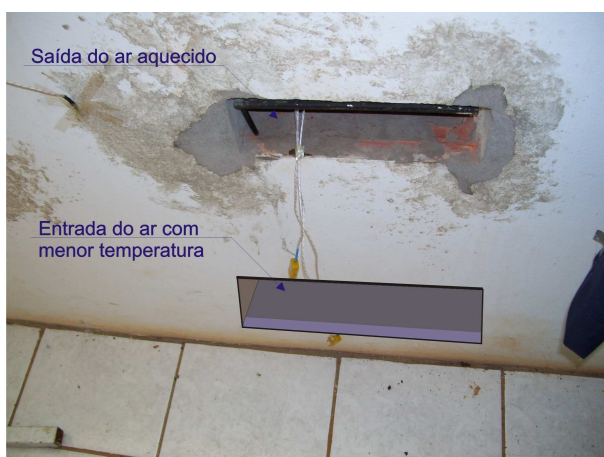
Figura 3 – Transformação do processo de aquecimento para ciclo fechado – esquema de funcionamento
