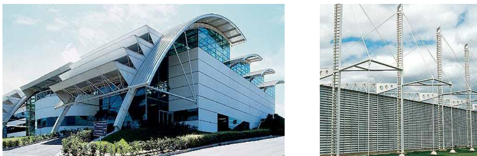
Figura 4: Fábrica Ipel (2000/01), arq. Sidôni Porto (Cajamar – SP); Indústria têxtil PW Brasil Export (2000/03), Elio Madeira Arquitetura (Colatina – ES); Fonte: http://www.arcoweb.com.br ; acesso em 02/12/2008
