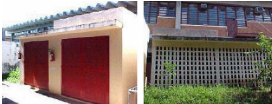
Figura 2 - Panorama da edificação onde está implantada a cobertura verde
