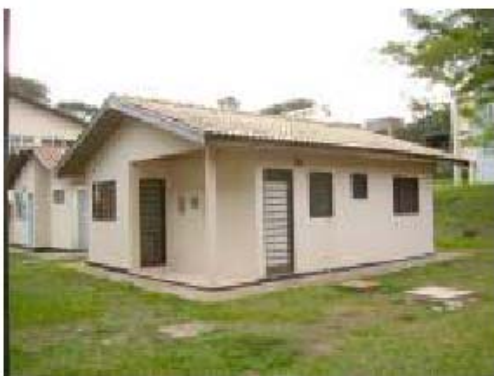
Figura 5 – Fachada protótipo de concreto celular Fonte: Carbonari (2007)
