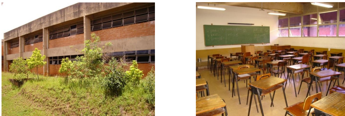
Figura 3 – Fachada oeste de um bloco do ICEB e sala de aula.
