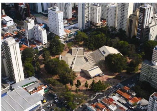
Figura 2 – Vista aérea da Praça Imprensa Fluminense, conhecida também como Centro de Convivência. Campinas, SP. Foto: Rodrigo Ruiz. Fonte: www.radiocamp.org/campinas . Acesso: mar. 2009
