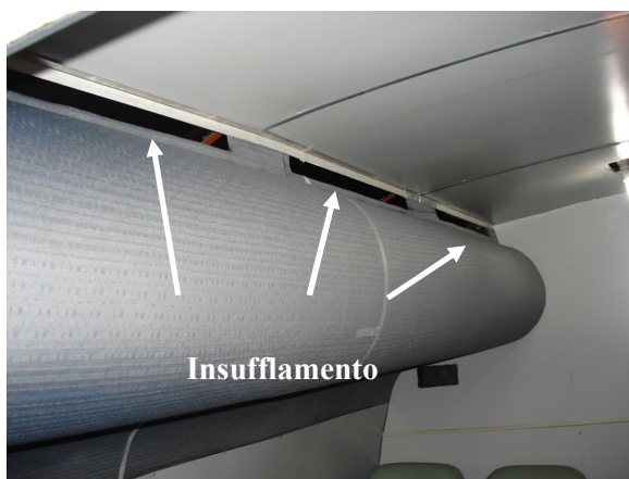
Figura 7 Detalhes do insuflamento e do retorno do ar no mock-up
