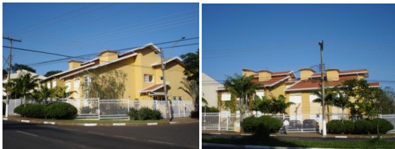
Fig. 1 – Edifício em estudo.
