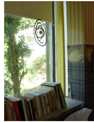
Figuras 24, 25 e 26 – Vãos pivotantes nas esquadrias dos quartos e da entrada principal
