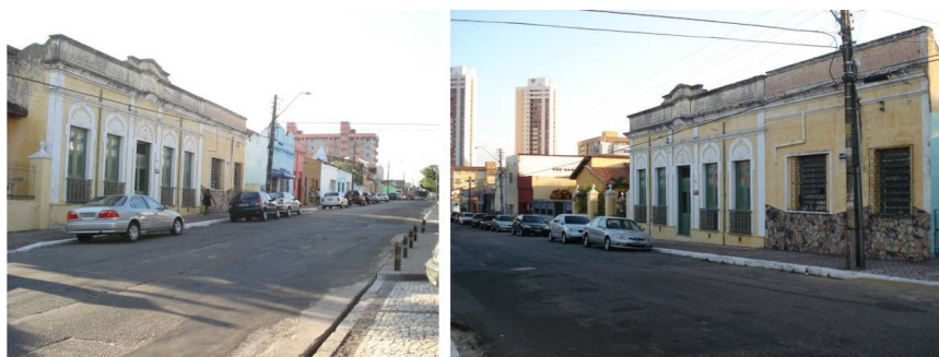
Figura 1 – Vista geral da Unidade 1
