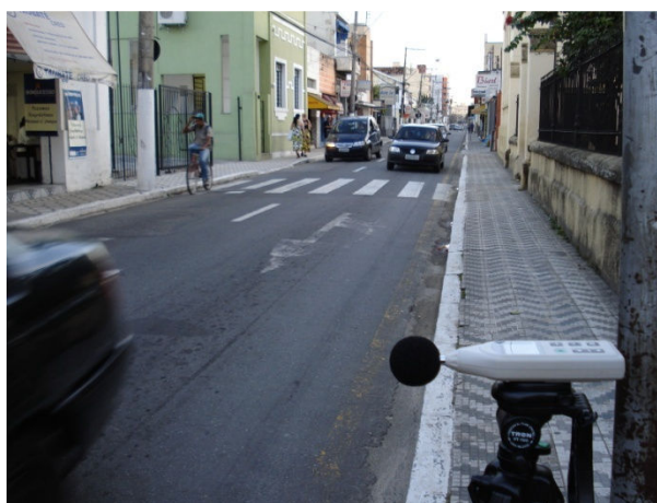
Figura 8 - Vista Rua Dr Pedro Costa, ponto de medição 21
