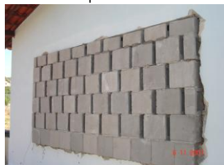
Figura 19. Foto do bloco tipo 2 assentado na fachada separado 5 cm
