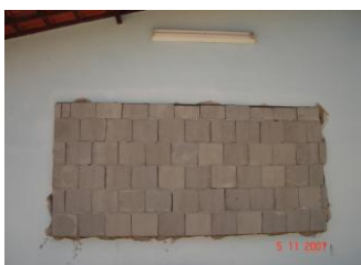
Figura 17. Foto do bloco tipo 2 assentado na fachada junto
