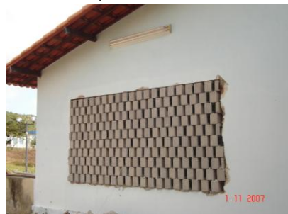
Figura 14. Foto do bloco tipo 1 assentado na fachada separado 5 cm
