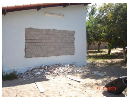
Figura 12. Foto do bloco tipo 1 assentado na fachada na fachada junto
