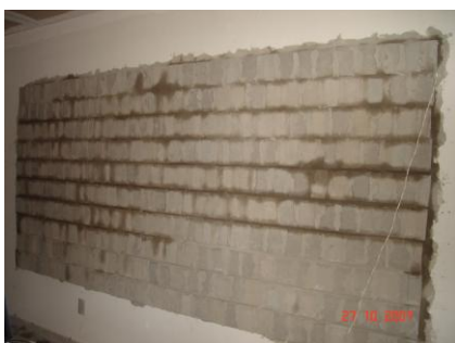
Figura 11. Foto do bloco tipo 1 assentado na fachada junto (interno)
