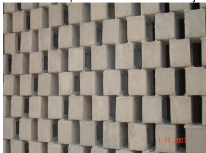
Figura 13. Foto do bloco tipo 1 assentado na fachada separado 5 cm
