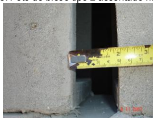
Figura 20. Foto do bloco tipo 2 assentado na fachada separado 5 cm
