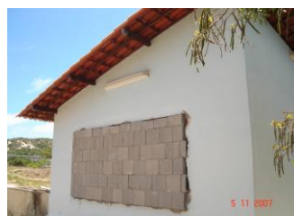
Figura 18. Foto do bloco tipo 2 assentado na fachada junto
