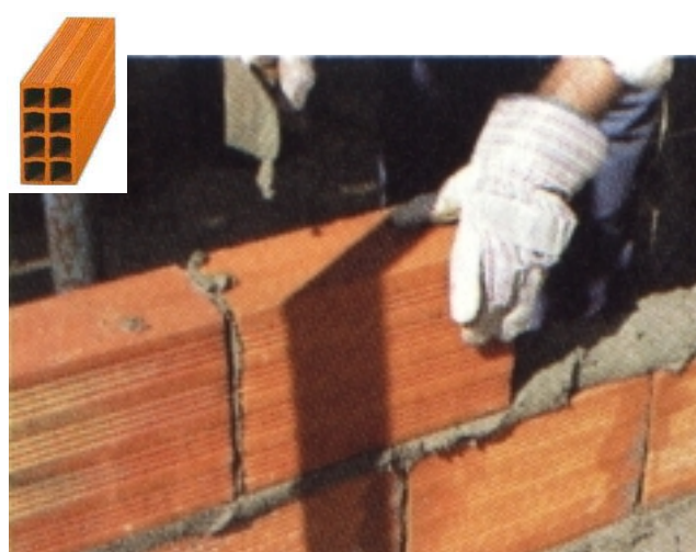
Figura 7: Construção de parede de tijolo cerâmico, em Portugal, com o uso da pá de pedreiro e, no detalhe, uma peça de tijolo cerâmico. (SERRA E SOUZA, 2000).
