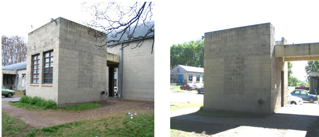
Figuras 1 y 2 – Fotografías del recinto del Laboratorio en su versión original
