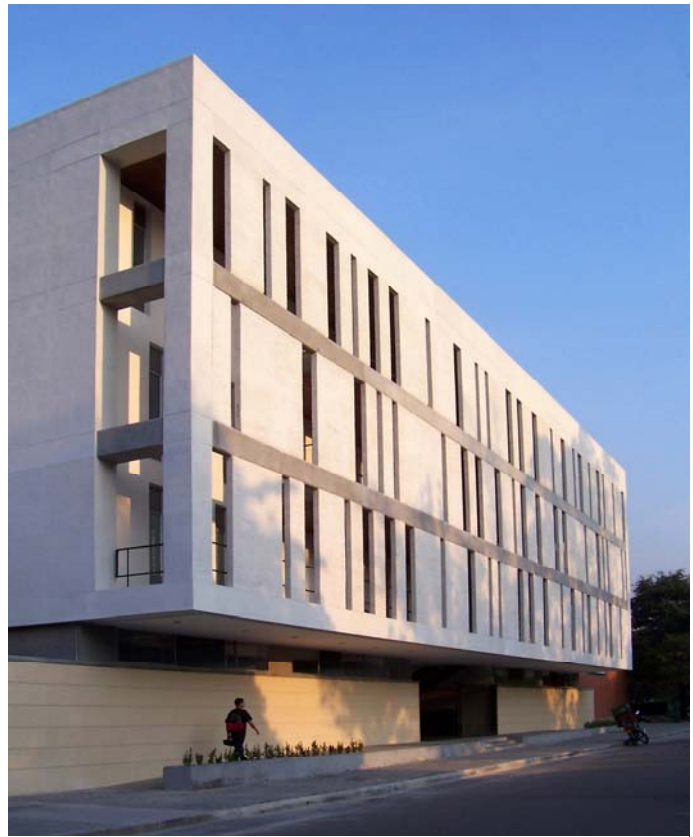
Figura 1. Fachada oriental del edificio de aulas de la Facultad de Ingenierías de la UPB en Medellín. Dieciséis aulas, cuatro por piso, que se iluminan y ventilan exclusivamente por sus fachadas oriental y occidental.
