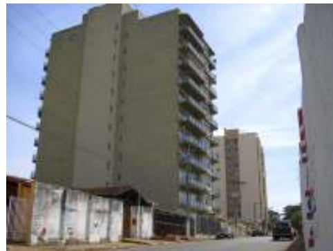
Fig. 3 – Prédios construídos sem afastamento da divisa dos lotes em Paracatu.
