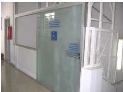
**Imagem 13 – Instalação inadequada de elevador - plataforma no edifício do FÓRUM em Presidente Prudente.**
