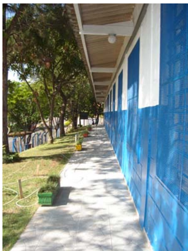
Figura 1 – Sala 2, EMEF Ângela Cury, aberturas parcialmente protegidas pela vegetação.
