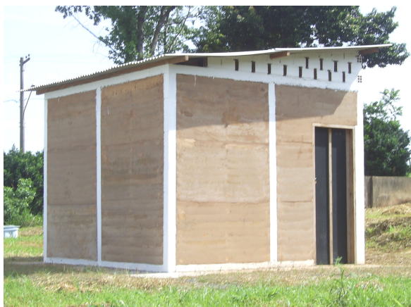
Figura 1. Fachada sul (porta) e fachada oeste da edificação-protótipo.
