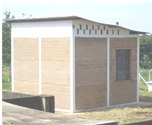
Figura 2. Fachada norte (janela) e fachada leste da edificação-protótipo.
