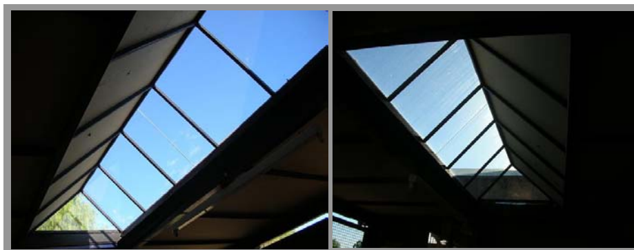
Figura 8: Fotografías del sistema en construcción en oficinas del LAHV
